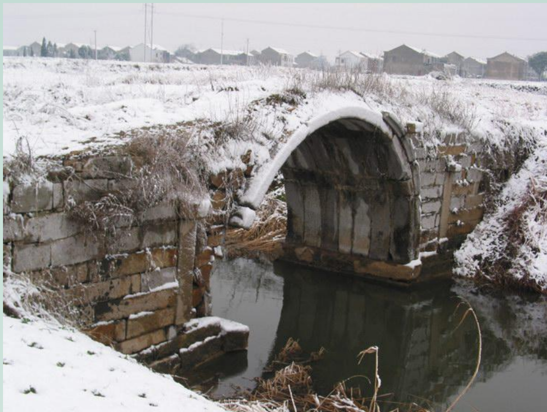
江阴南闸涂镇横沟桥
