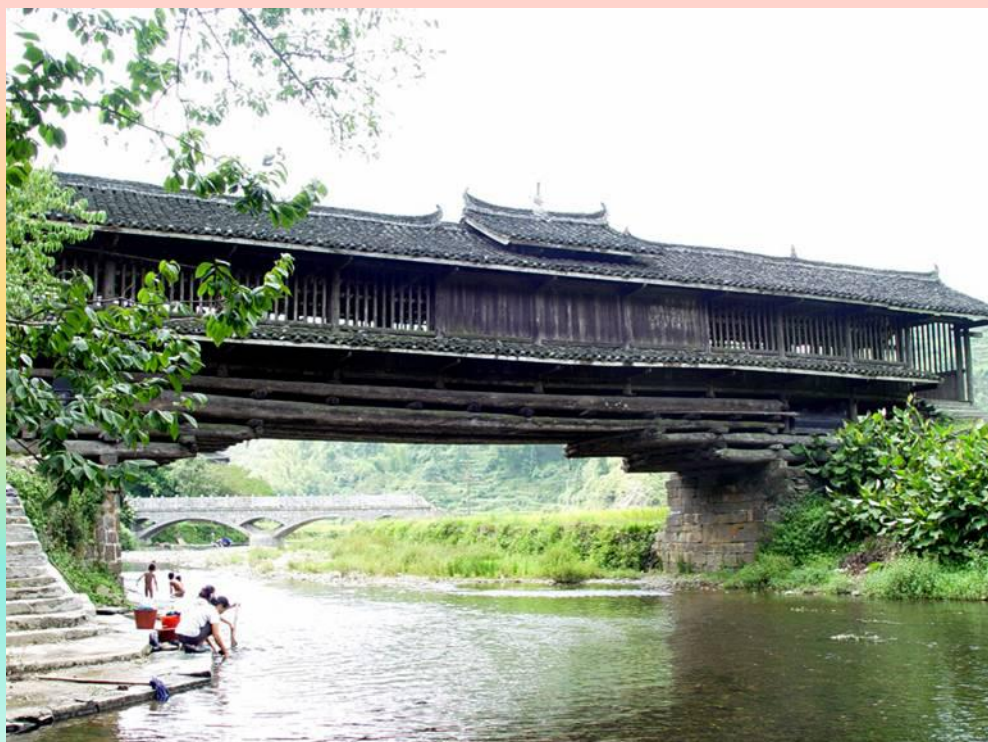
永福桥（湖南省通道县 单向伸臂木梁廊桥）
