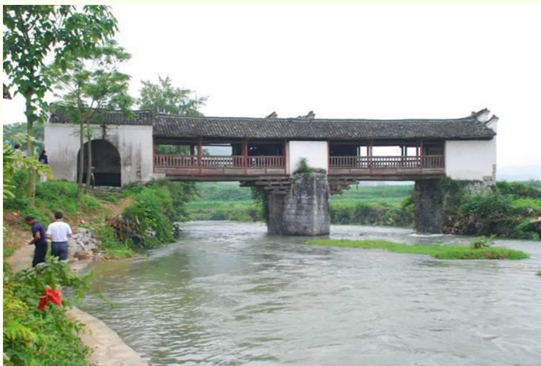
广济桥（湖南省郴州市 石尖墩木伸臂木梁桥）
