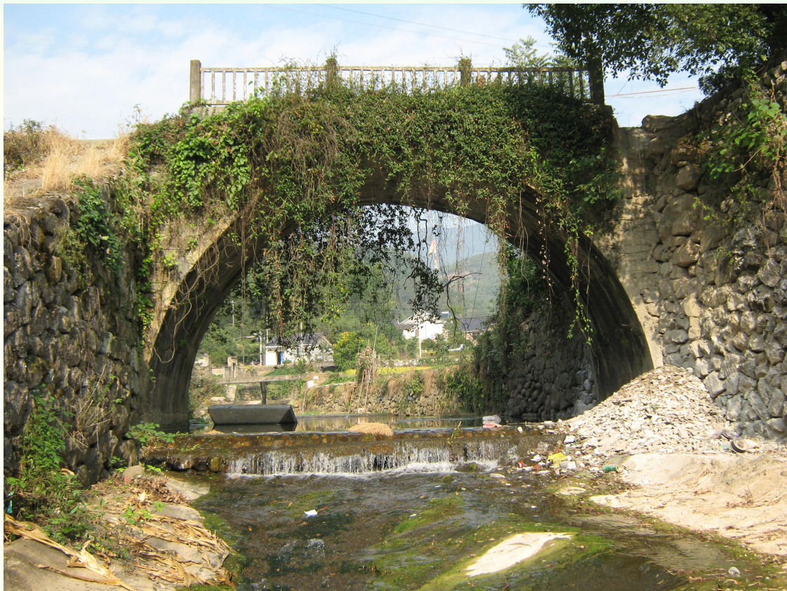
白云桥。此桥位于余姚市。桥高 8 米，桥跨 12 米，桥长 24 米，桥拱超过半圆，这是七锁八链与半圆相连接的多心圆弧链锁拱桥。
