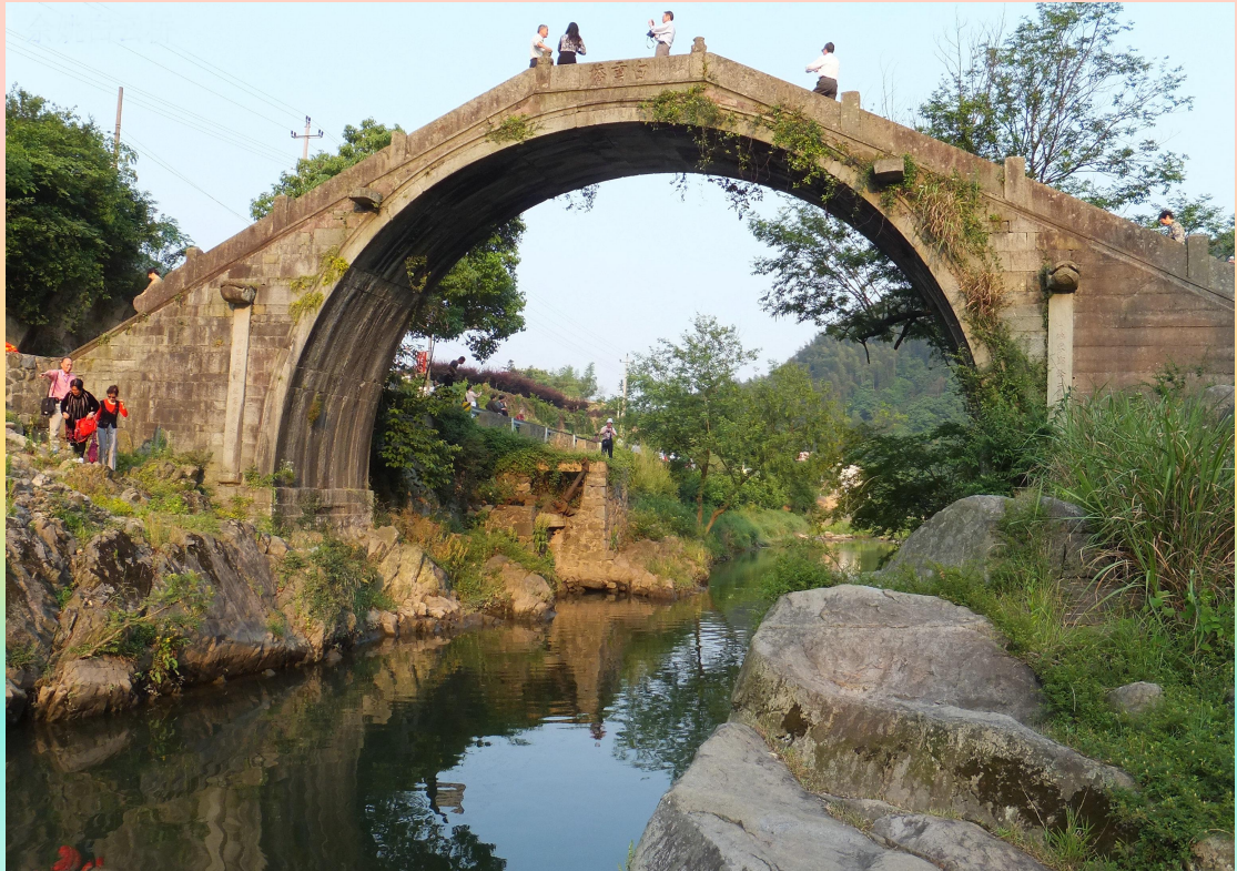
白云桥。此桥位于余姚市。桥高 8 米，桥跨 12 米，桥长 24 米，桥拱超过半圆，这是七锁八链与半圆相连接的多心圆弧链锁拱桥。
