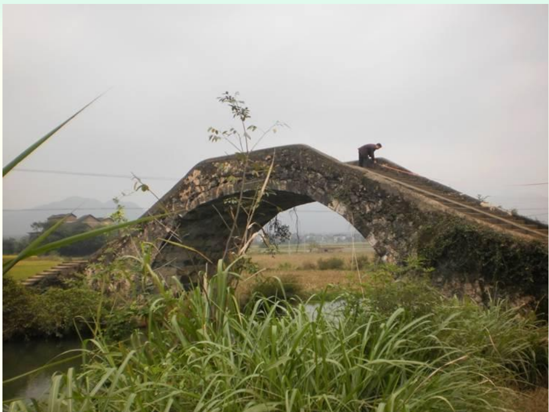
与半圆相连接的多心圆弧链锁拱桥
