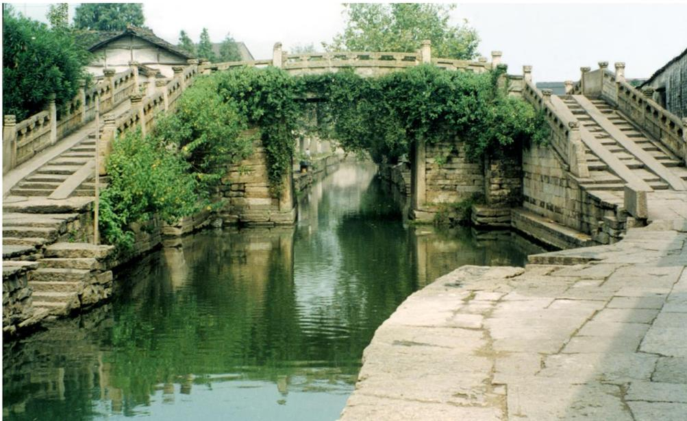
八字桥桥模和桥照表明纤道没有穿过桥洞，故八字桥不是立交桥
