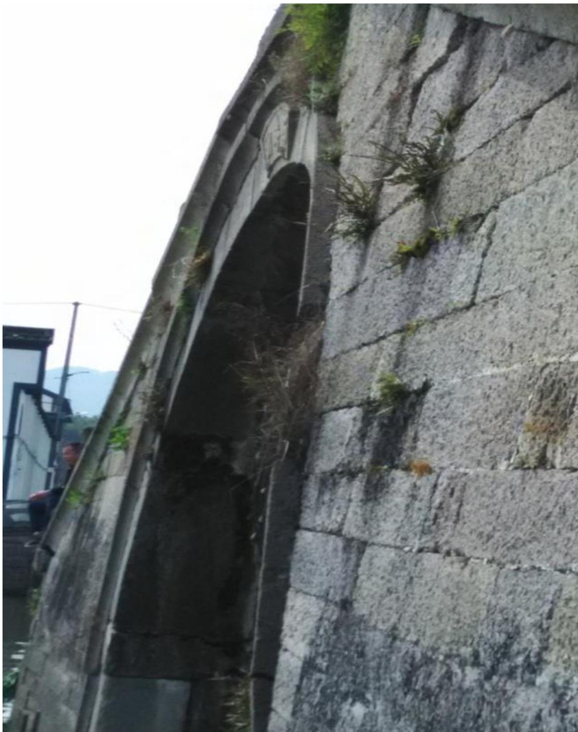
西跨湖桥（桥拱变幅 4 厘米，全桥变幅 26 厘米）
